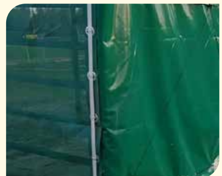
Befestigung mit verstärkten Metallösen und Band
