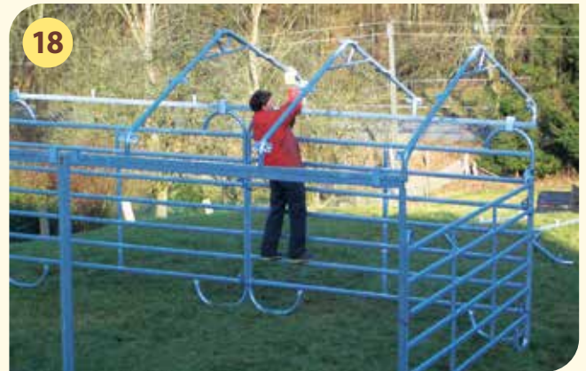
18 Winkel-Dachbögen E auf das Verbindungsstück aufsetzen
