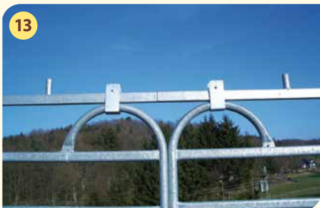
fertig verschraubtes Verbindungsstück mittels Befestigungswinkel an den Panels
