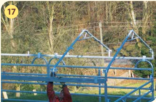
17 Winkel-Dachbögen E auf das Verbindungsstück aufsetzen, doppelte nach innen
