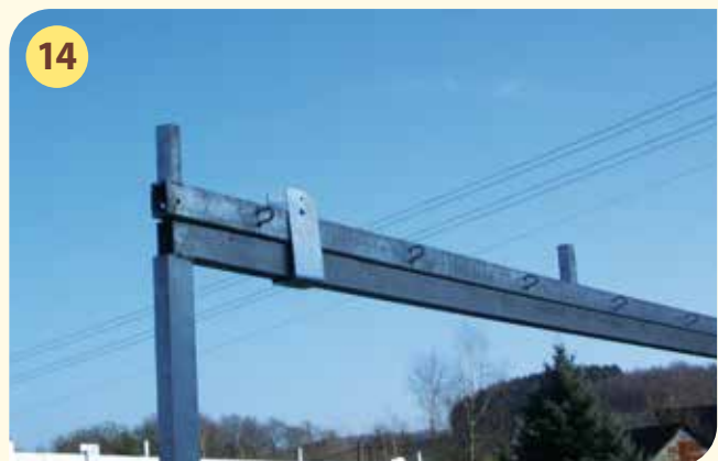
Ösen an dem Vierkant-Verbindungsstück zeigen nach außen und dienen zur Befestigung der LKW-Dachplane
