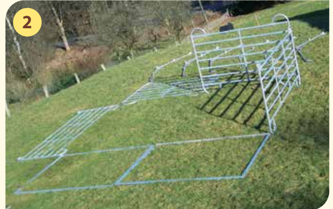
2 Die ersten zwei Panels als Ecke miteinander verschrauben (Schraube M8 x 100) B C
