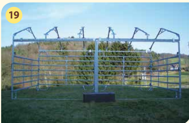
19 alle 6 Winkel-Dachbögen E + F sind montiert
