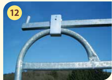
Vierkant-Verbindungsstück D auf die Seitenpanels legen und mit Befestigungswinkel L verschrauben (M8 x 70). Der Schraubenkopf muss nach außen zeigen.
