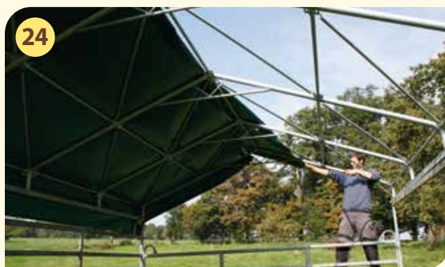
Aufziehen der LKW-Plane I auf die Dachkonstruktion
