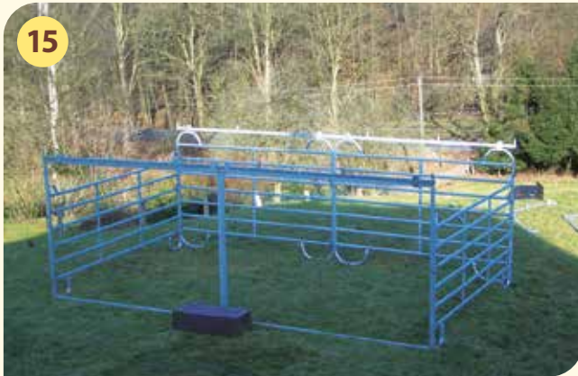
15 fertiges Gerüst aus Panels und Verbindungsstücken, bereit für die Dachkonstruktion
