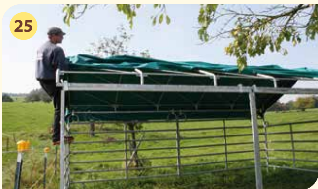
Aufziehen der LKW-Plane I auf die Dachkonstruktion
