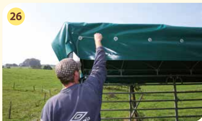
Stahlseil K durch die Ösen ziehen
