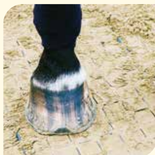
HAAS Grid H35 verfüllt, ohne Tretschicht
