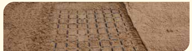
HAAS Grid H35 verfüllt, Sand als Tretschicht
