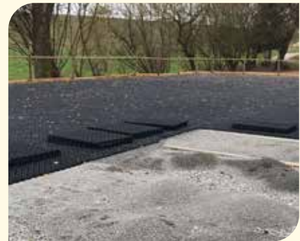
HAAS Grid H35 beim Verlegen
